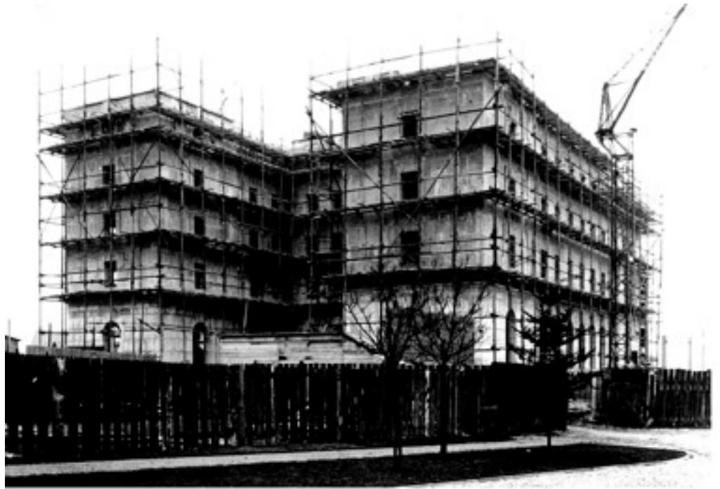
Estado de las obras, diciembre 1930
