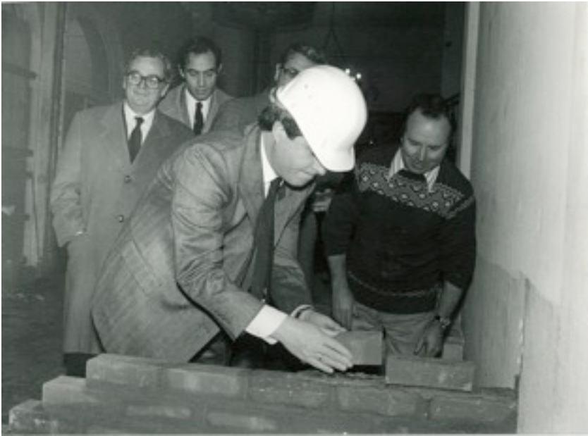
Début des travaux de restauration du Colegio, 4.12.1985
