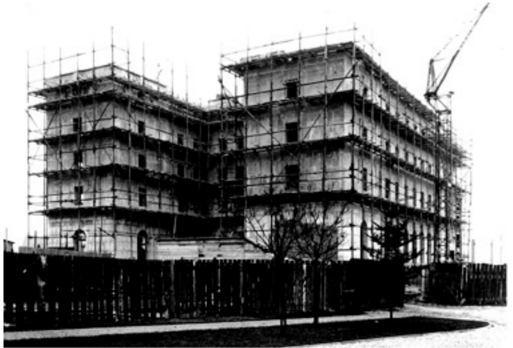
Etat des travaux, décembre 1930
